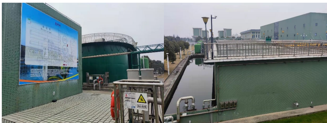
图E-1 污水处理设施
